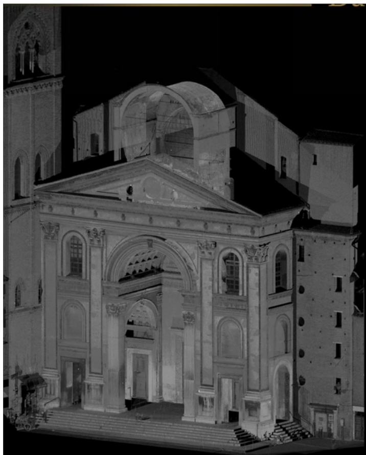
Figura 4 – Facciata della Basilica di S. Andrea acquisita con il sistema Laser Scanning
